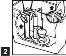
**2** Retire la válvula que va a sustituir, incluyendo el flotador y la manguera de llenado del espejo de agua.
